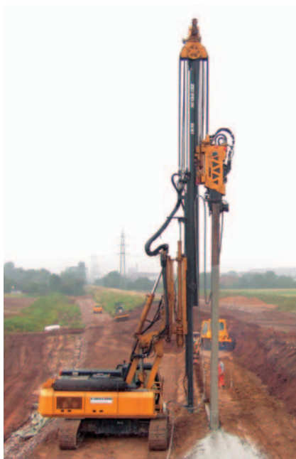
Schmalwandherstellung mit RG 18 T Construction of VIB-wall with RG 18 T
