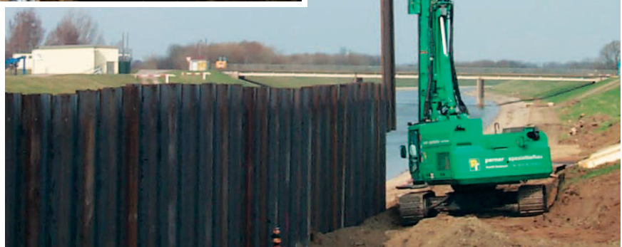
RG 16 T mit Presse MPU 600 (Einpressen von Spundwänden) RG 16 T with press-system MPU 600 (Pressing of sheet piles)
