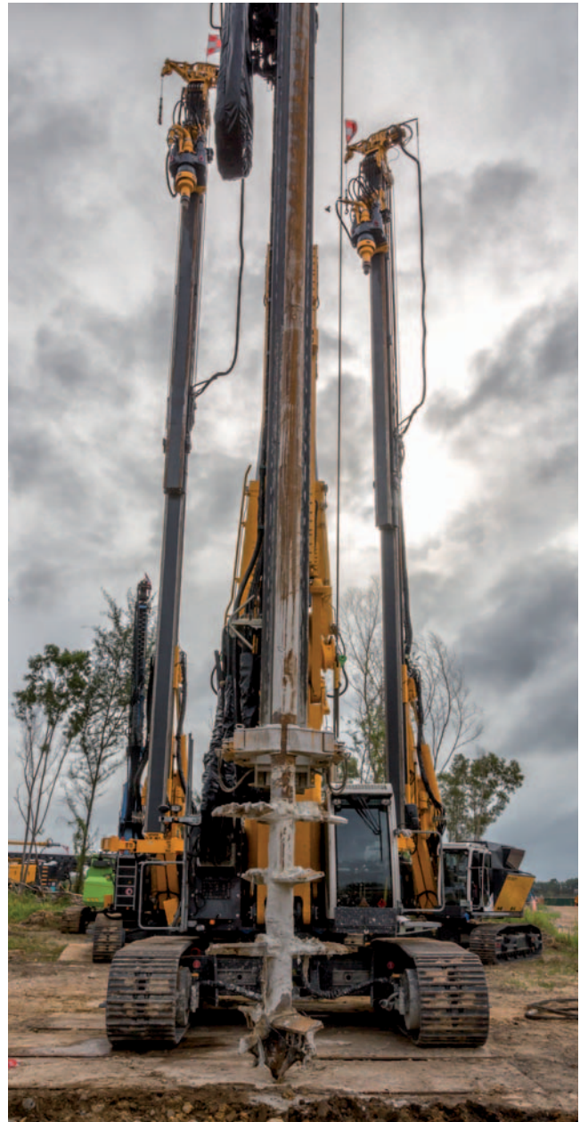
Bodenmischen mit Einzelpaddel an RG 25 S Single column mixing on RG 25 S
