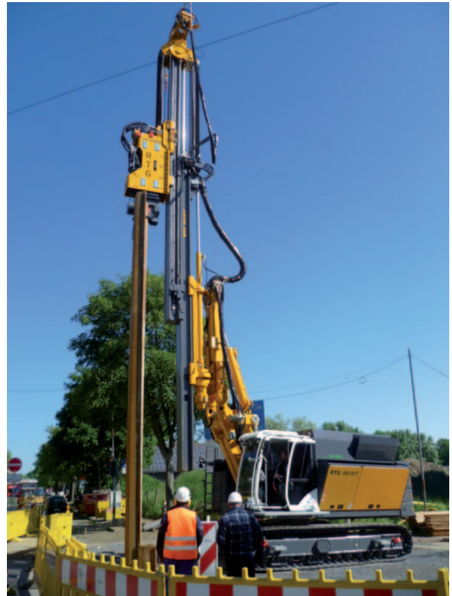
Spundwandeinbau mit Rüttler MR 150 AVM an RG 16 T Sheet pile installation with vibrator MR 150 AVM on RG 16 T
