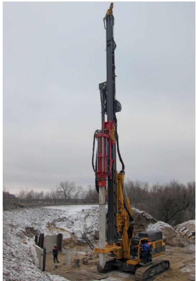
RG 22 S mit FAMBO Hydraulikhammer RG 22 S with FAMBO hydraulic hammer www.fambo.se
