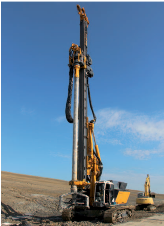
Bodenmischen mit Doppelkopfantrieb an RG 18 S Single column mixing with double rotary head on RG 18 S
