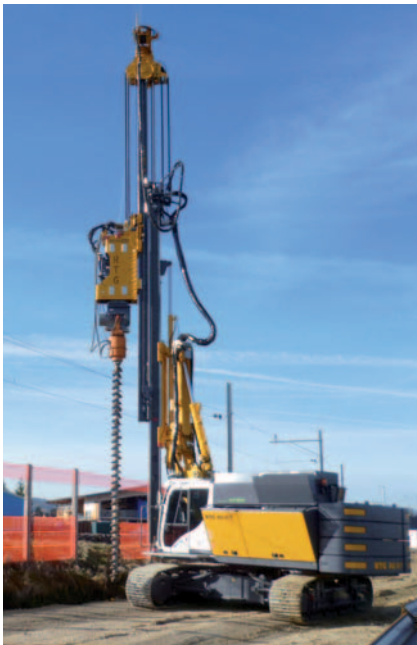
Vorbohren mit RG 19 T Predrilling with RG 19 T
