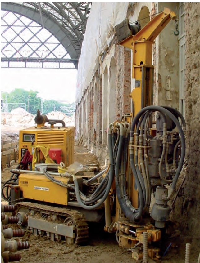
KR 702-2 mit Hydraulikhämmer KD 1011 with hydraulic drifter KD 1011
