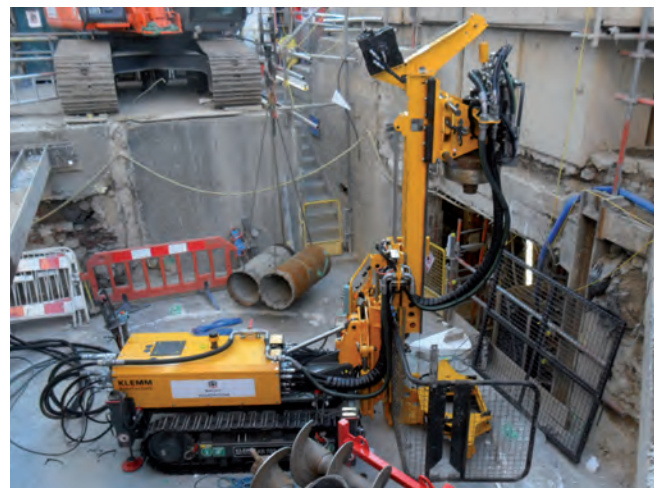
KR 702-2 mit Drehantrieb KH 20 und Sicherheitskäfig with rotary head KH20 and safety cage
