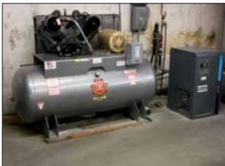
CAS 7.5 HP HORIZONTAL TANK AIR COMPRESSOR MODEL B73H126
