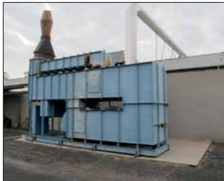
THERMAL OXIDIZER RTO SYSTEM
