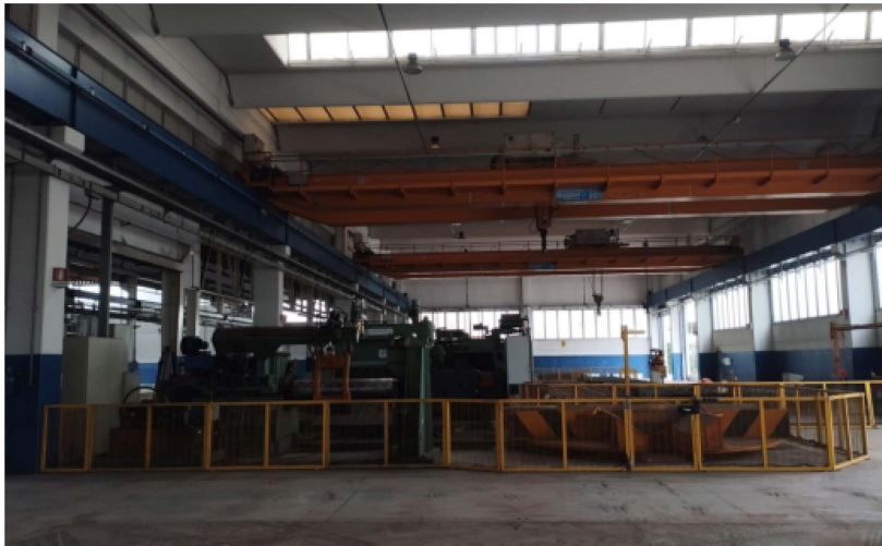
Vista generale linea / General line view
