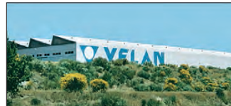
Lisbon, Portugal Velan Válvulas Industriais, Lda.
